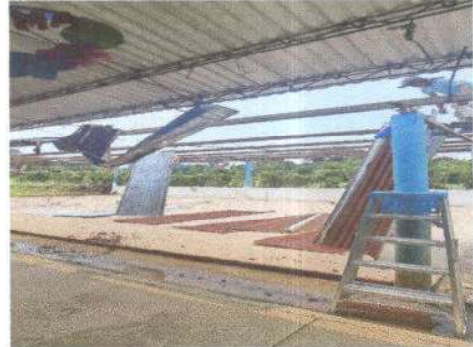
Foto 2: Estructura de techo
