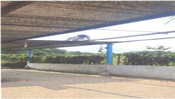
Foto 1: Cubierta de lamina.
