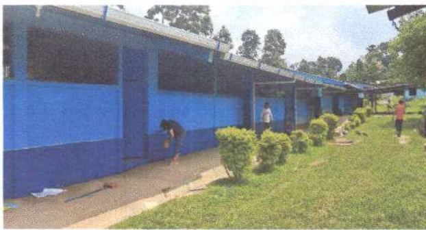
Foto 5: Pintura de muros exteriores e interiores.
