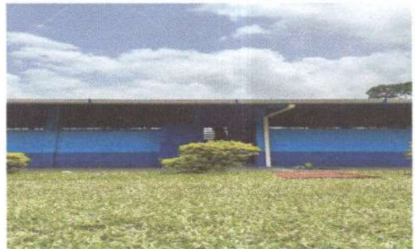
Foto 4: Canal y bajadas de agua pluvial.
